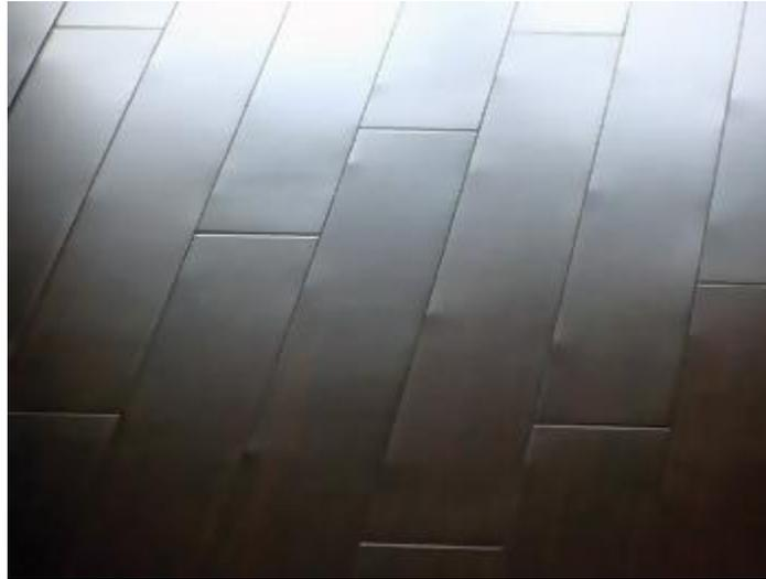
**La fotografía de abajo muestra los daños causados por el uso de fuerza excesiva y posición inapropiada de la clavadora**
